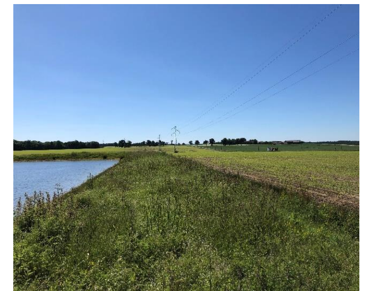
Photographie prise sur site du haut de la retenue collinaire (digue). À droite en contrebas la zone humide de la Grande Besse NORD (Berneuil n°1).
