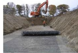
recouvrement de terre végétale
