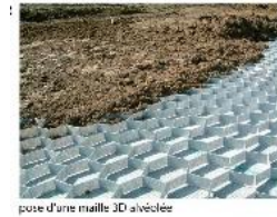
pose d'une maille 3D alvéolaire
